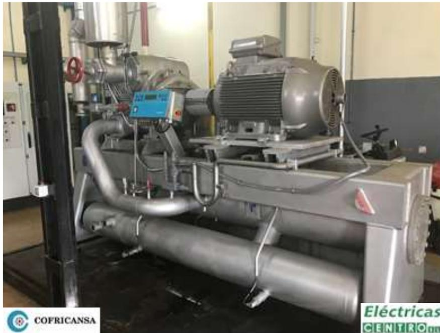
Motor de imanes permanentes de la marca WEG modelo Wmagnet accionando un compresor Howden
